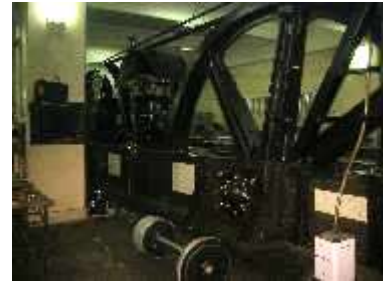
駅地下に設置された巻上機
